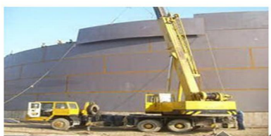
图 5.10 大型储罐吊车就位壁板
