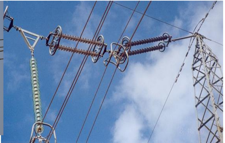
400KV 倒三角绝缘子串组合布置实景图例（南非）
