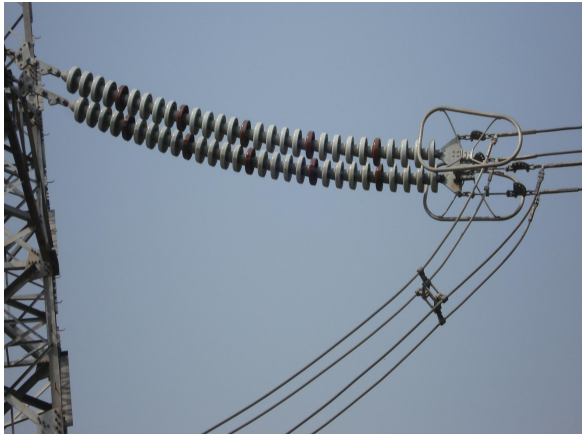
某输电线路绝缘子串耐张组合布置实景图例
