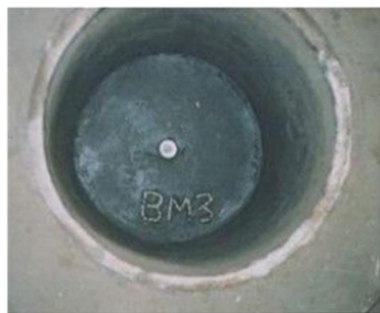
图13-3-1 基准点保护
