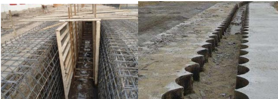
地下连续墙、咬合灌注桩、预制钢筋混凝土板桩
