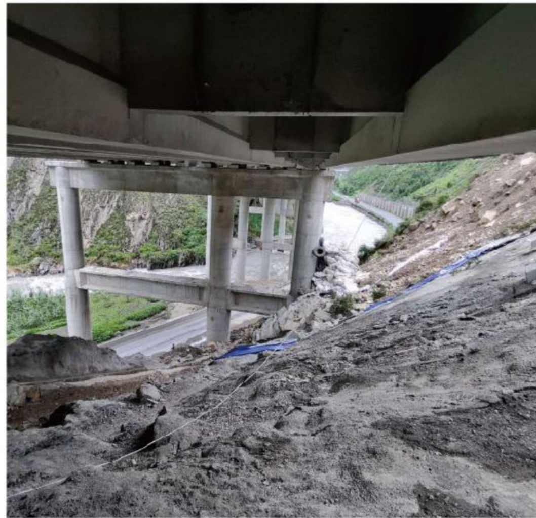
汶马高速K94唐家湾边坡滑坡局部滑塌影响桥墩
