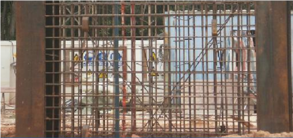
安装后随地连墙埋设
