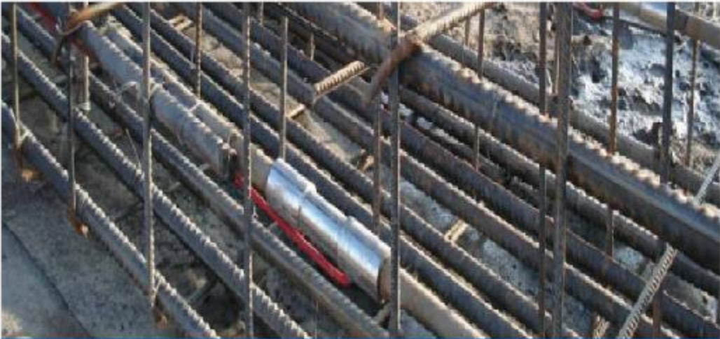
支撑梁应力计安装
