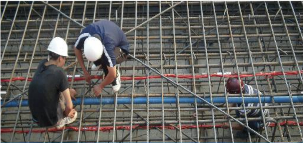
地连墙应力计安装
