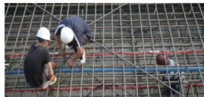
地连墙应力计安装
