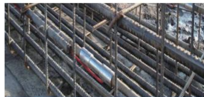
支撑梁应力计安装
