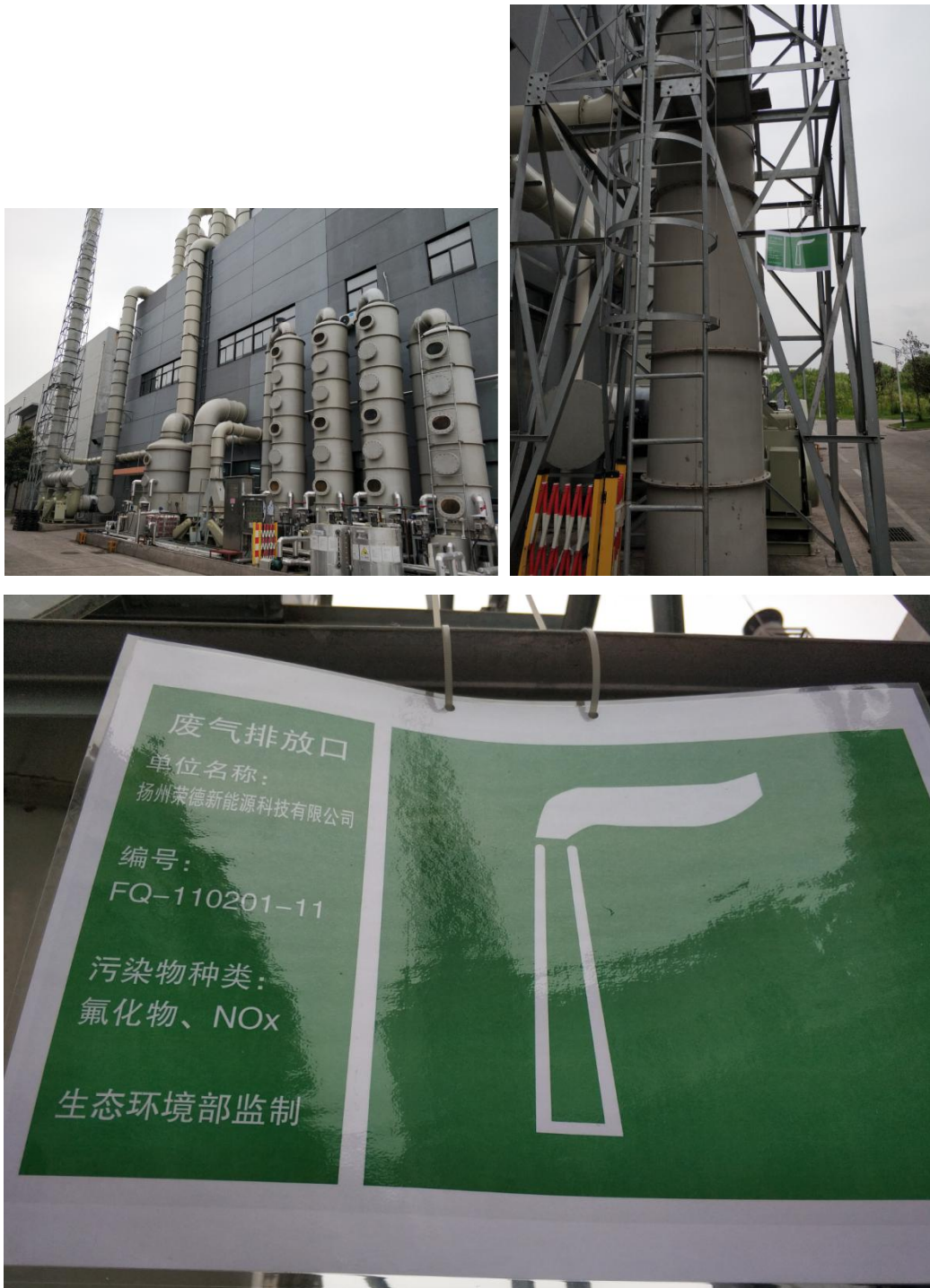
图 5.5.1-4 硅料清洗酸性废气处理装置现状图（11#排气筒）
