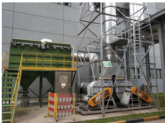
图 5.5.1-2 坩埚喷涂废气处理装置现状图（9#排气筒）
