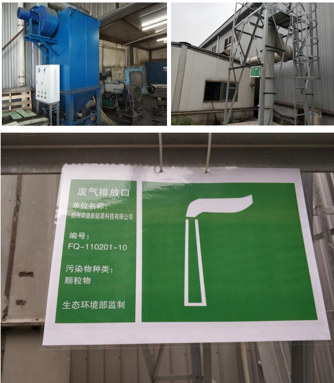
图 5.5.1-3 废线切割粉尘废气处理装置现状图（10#排气筒）
