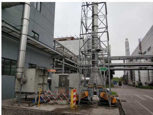
图 5.5.1-1 铸锭炉真空泵油烟处理装置现状图（8#排气筒）
